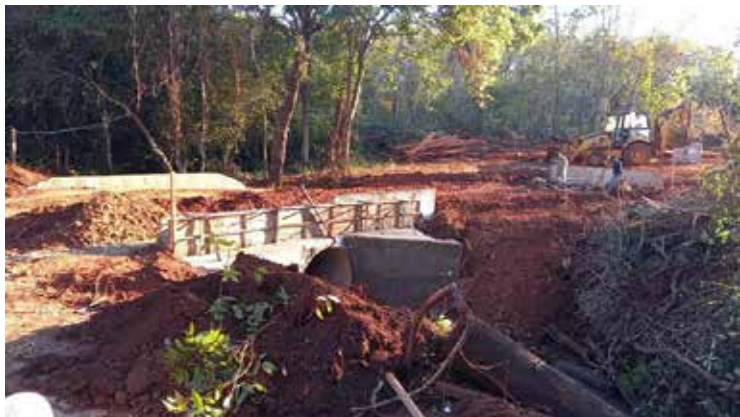
Prefeitura de Panamá substitui pontes de madeira para concreto e manilhas na zona rural do município
