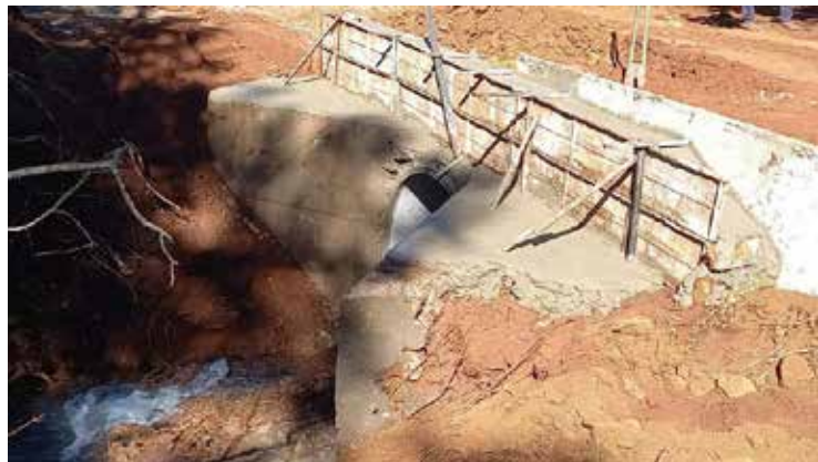
Prefeitura de Panamá substitui pontes de madeira para concreto e manilhas na zona rural do município
